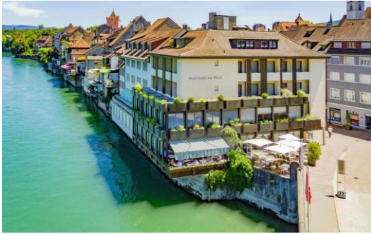
Luftaufnahme Hotel Schiff. Bild: Markus Raub/RMP Media Production GmbH
